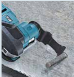
Cắt thép cốt sắt bề mặt
