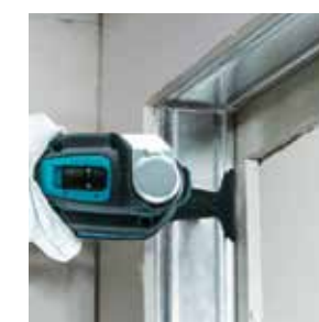
Công việc phá cửa
