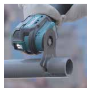
Cắt ống PVC, FRP
