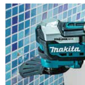
Cắt đường nối tường gạch
