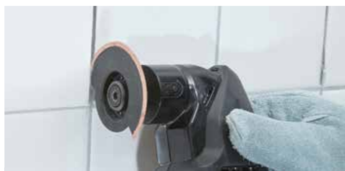
Cắt đường nối trên tường gạch TMA023, TMA024, TMA026
